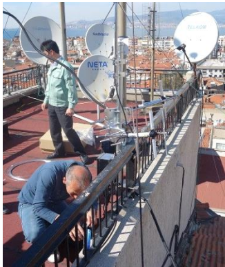
トルコにて設置作業をする当社社員と現地スタッフ
