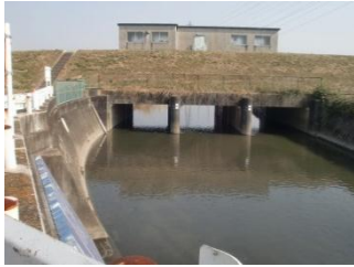
大川排水機場逆流水門全景
