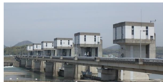
放流警報装置更新中の加古川大堰
