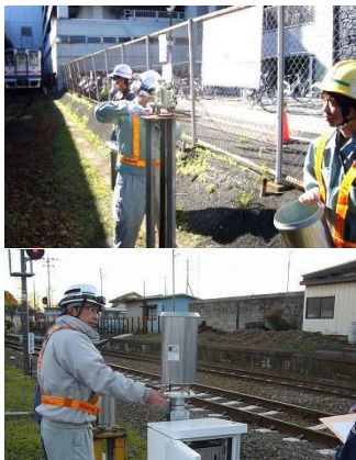
気象観測機器の設置作業
