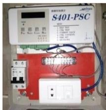
設置した制御用地震計S401-PSC
