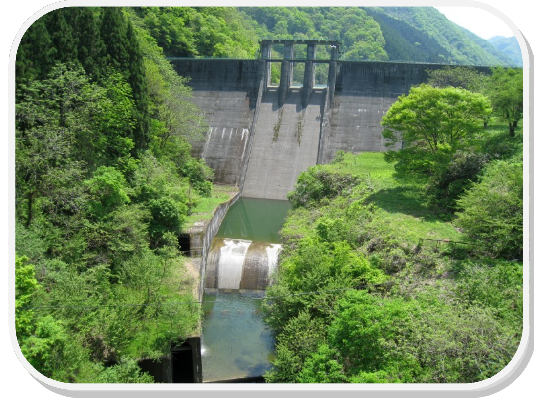
宮川ダム（福島県大沼郡会津美里町）
