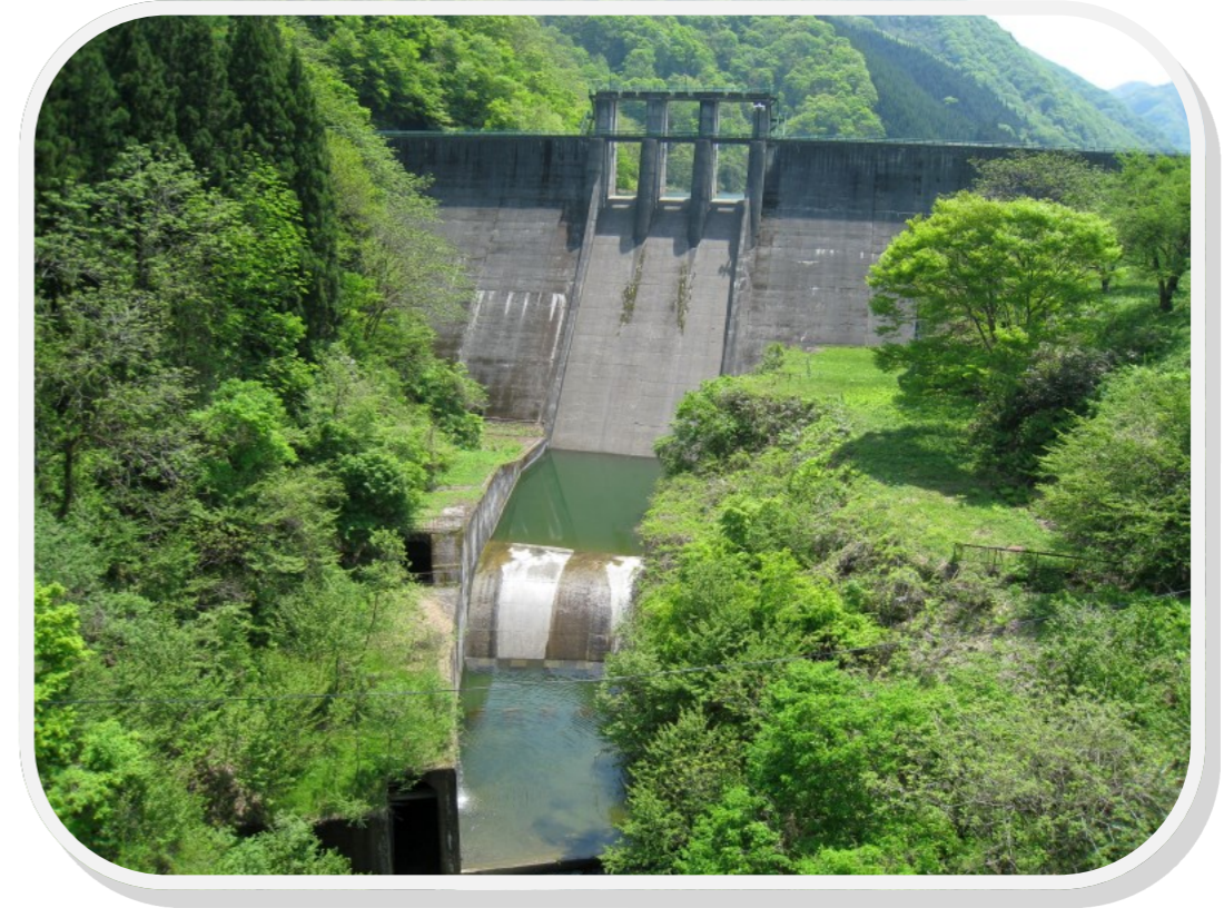
宮川ダム (福島県大沼郡会津美里町)
