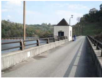
京丸ダム天端部
