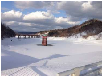
雪に埋まっている穂別ダム の手前手すり部分がダム天端部、中央は取水塔
