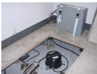
計測震度計 設置例
