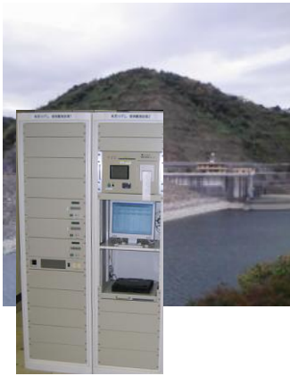
末武川ダム全景と 漏水観測システム(左)
