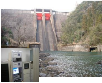
綾南ダムと管理事務所機器室に設置された地震観測システム計測震度計
