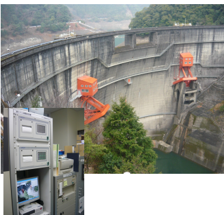
綾北ダムと管理事務所に設置された地震観測システム
