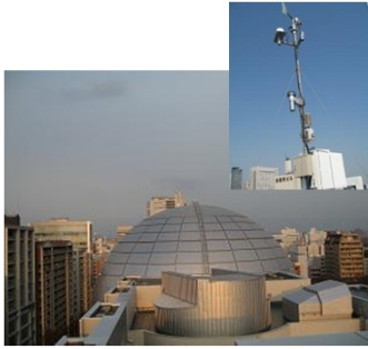
名古屋市科学館様プラネタリウム隣に 新設された気象測定装置
