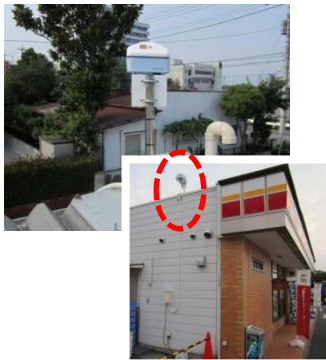
セーブオンに設置したPOTEKA Sta.
