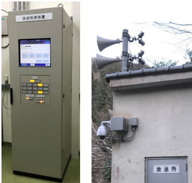
放送制御装置(左)と放送所
