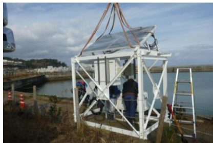
太陽電池パネルの取り付け
