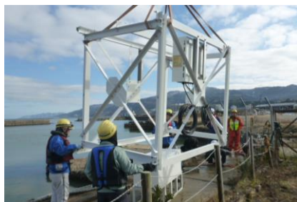
観測装置架台の設置
